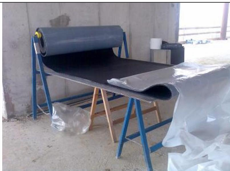
L'attività consiste nell'applicazione di una guaina isolante adesiva applicata alle condotte scatolari in lamiera. Per l'esecuzione di tale attività viene utilizzato un banco da lavoro posizionato di volta in volta ai vari piani delle torri. Un tubo portarotolo facilita le operazioni di applicazione della guaina coibente.
