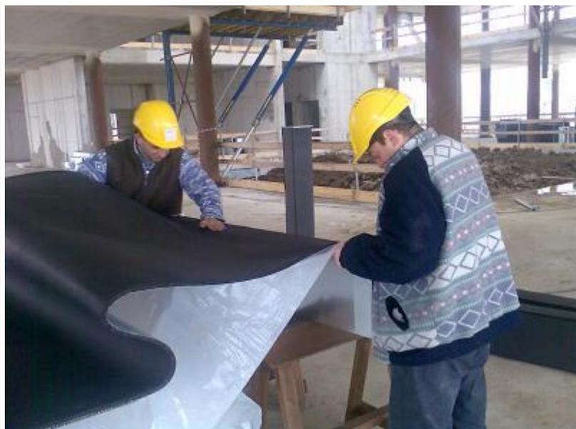
Il tubo viene fatto ruotare ed il canale viene interamente rivestito.
