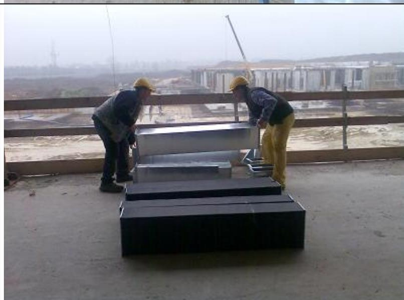
Due addetti movimentano i canali da isolare e li pongono sopra un banco di lavoro.
