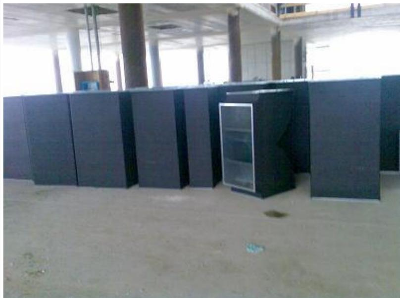
I singoli elementi vengono rivestiti con la guaina adesiva e ridistribuiti sul piano in funzione delle necessità
