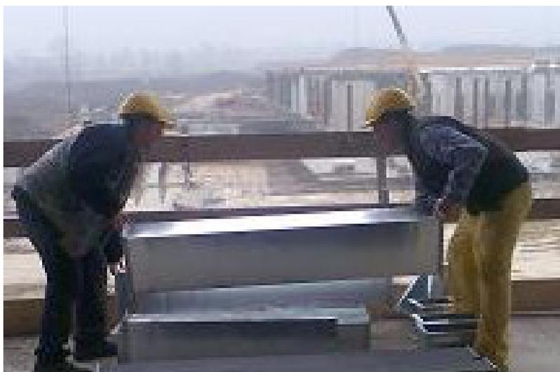
Gli elementi di canale vengono forniti al piano tramite il sollevamento ed il posizionamento sulle pedane di carico dalla gru di servizio del cantiere. La movimentazione avviene inserendo i tubi più piccoli all'interno dei tubi più grossi e facendo passare una fascia all'interno del canale più interno. Distribuiti con la gru sui vari piani, gli elementi vengono stoccati in più punti del piano per poter procedere alla coibentazione
